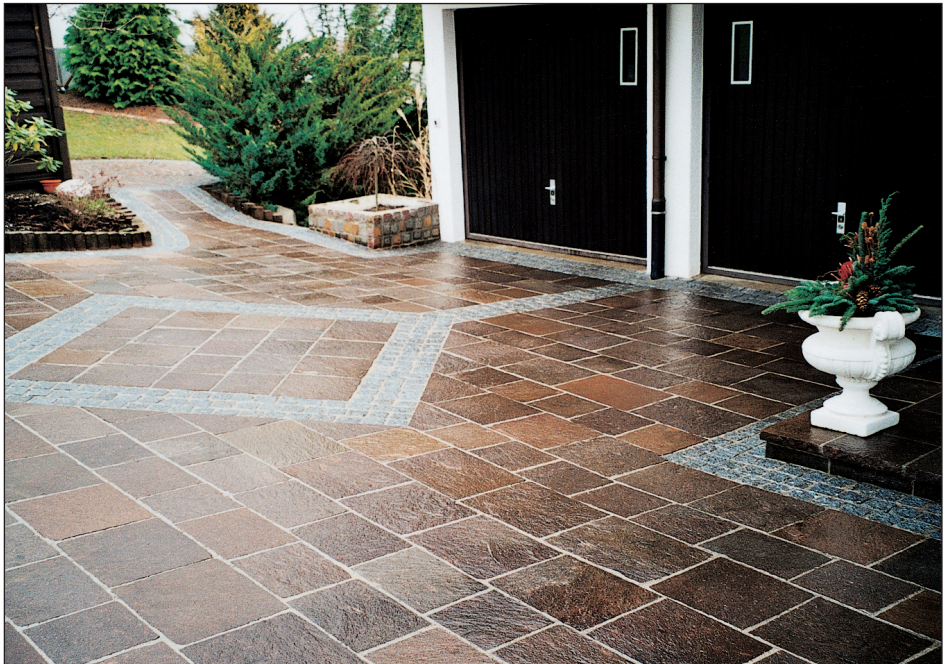
Porphyr-Platten in Bahnen mit Granit-Pflaster 9/11
